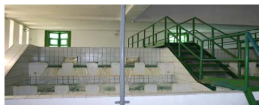
Bogatenje vode v Vodarni na Vrbanskem platoju
