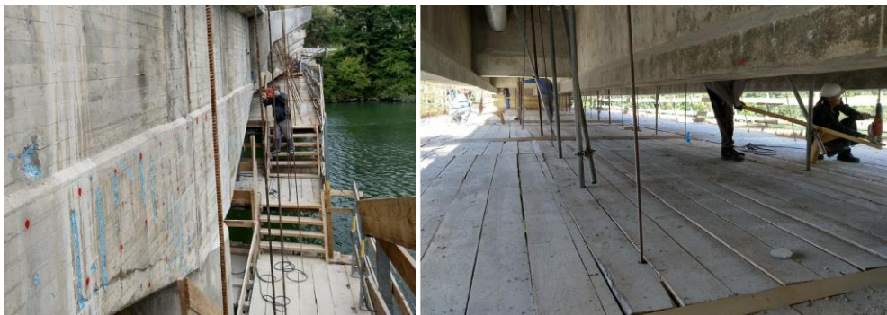
Sliki: Dela na mostu (sliki in besedilo povzeto po zapisniku operativnega sestanka)
