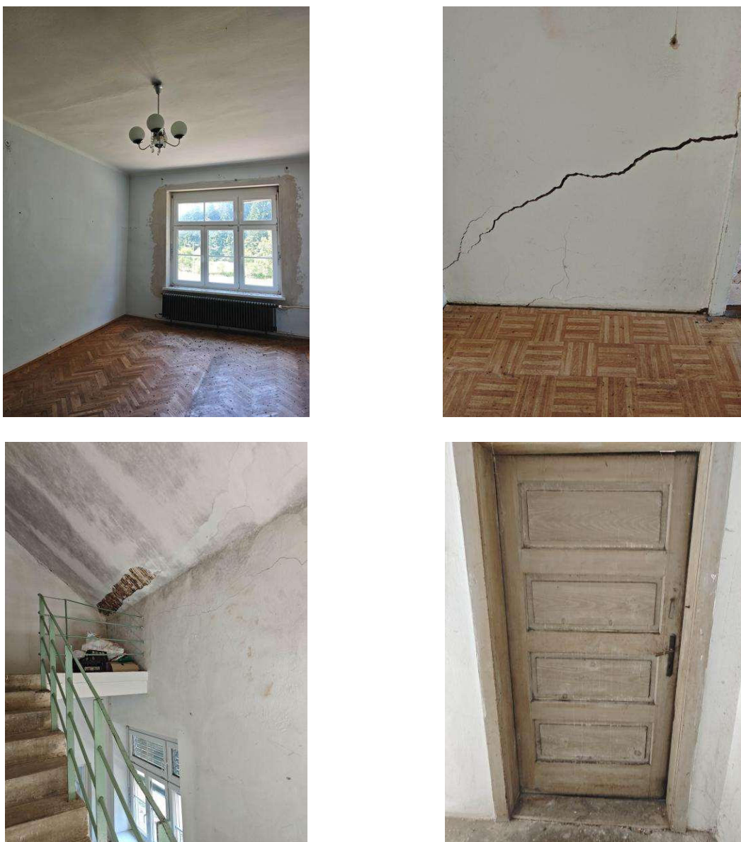
Slika 1: Obstoječe stanje OŠ Gradišče.
